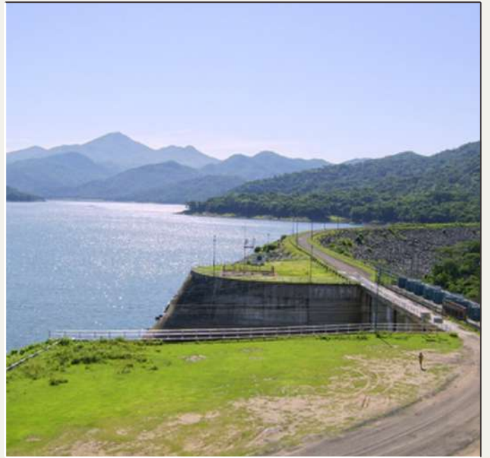
Presa Cajón de Peñas
